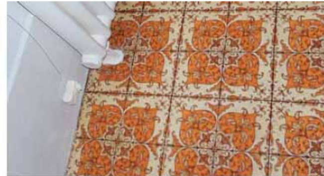
Modèle typique d'un revêtement de sol multicouches amianté
