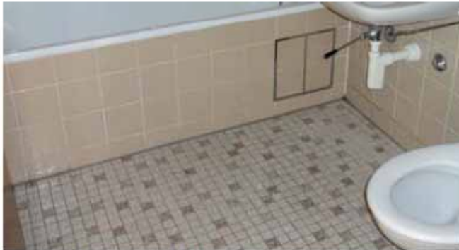
Carrelages et faïences avec colle amiantée
